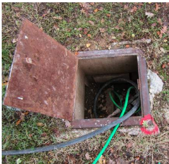
Slika 6. Priključak za vodu van postojećeg groblja
